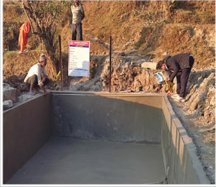
वडा नं.२ मा निर्माण भएको बाह्रकिलो सिचाई पोखरी
